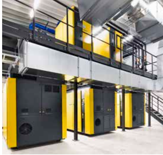
左の画像:巨大なフォイルシートがこれらのタワー型押し出し成形機内で生産されています。右の画像:これらの新しい圧縮空気ステーションは、スペースを節約するために2段に配置されています。
