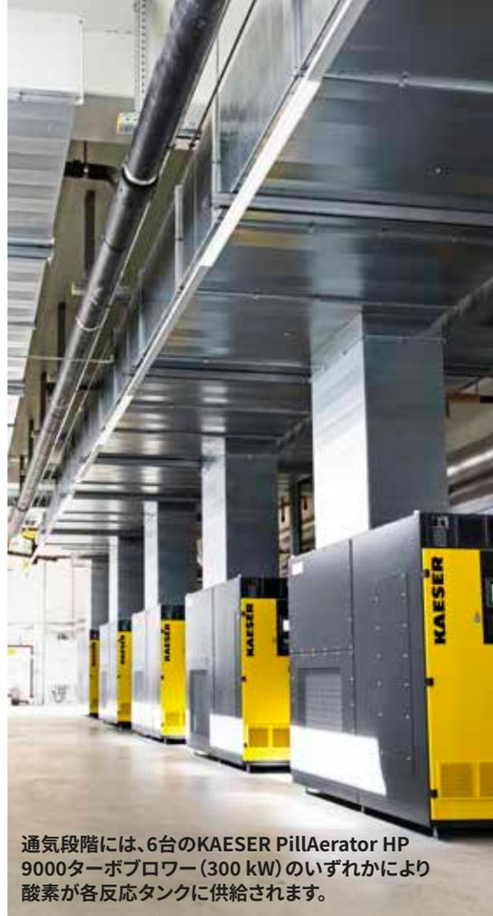
通気段階には、6台のKAESER Pillaerator HP 9000ターボブローワー(300 kW)のいずれかにより酸素が各反応タンクに供給されます。
