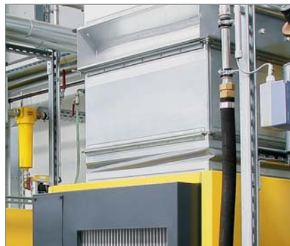
図2: キャンバスダクトジョイントによるコンプレッサーの換気接続
